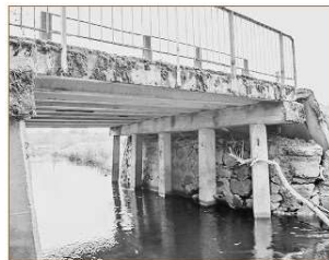
GRŪSTĪSAIS TILTS PĀR ZALVĪTES UPI. Labā krasta stiprinājums atspiedies pret vienu no tiltu balstiem.
