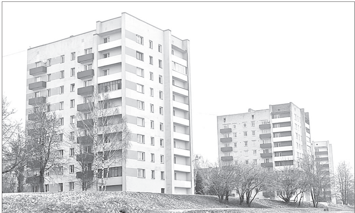
ATŠKIRĪBA JŪTAMA. Maksa par apkuri renovētā un nerenovētā mājā atšķiras pat divas reizes, un tā ir labākā motivācija iedzīvotājiem lemt par labu mājas siltināšanai.
